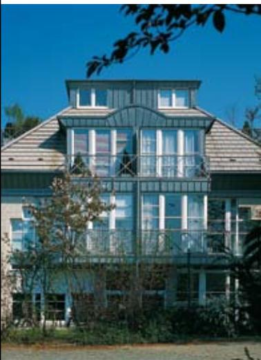
Als zweischalige Ausführung mit der Möglichkeit sehr großer Dämmstoffdicken ist die hinterlüftete Außenwandbekleidung bauphysikalisch unübertroffen.
