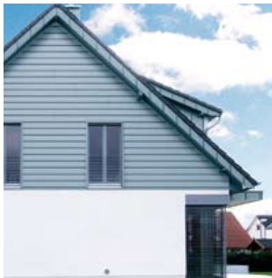
Hinterlüftete Außenwand-Bekleidung
